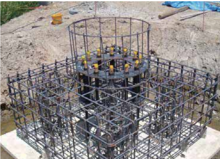
歩道橋基礎用アンカーフレーム
