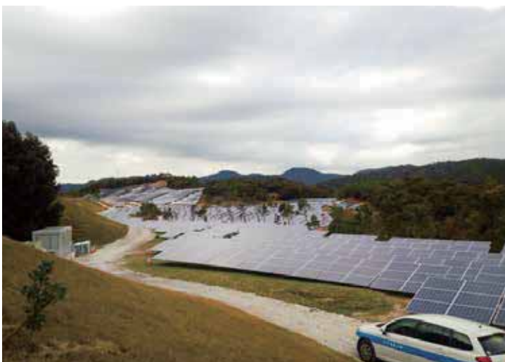
PV架台・PVアンカー
